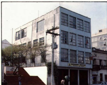
Fachada do Quartel – Passo Fundo
