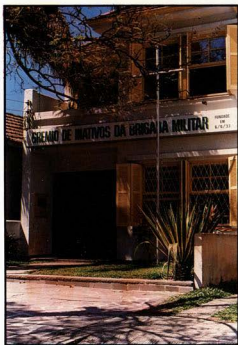
Fachada do GIBM, à rua Casemiro de Abreu nº 299 – Porto Alegre
