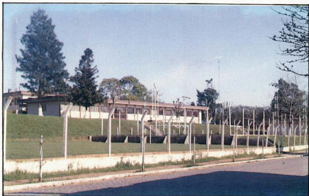
Fachada do Quartel – Rio Pardo
