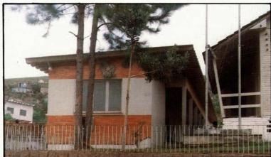
Fachada da DP16 - Seção de Assistência Social, à rua Volta da Cobra n: 52.
