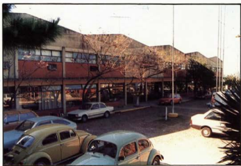
Instalação do AR/1 e AR/2 (Supermercado da BM) Av. Aparício Borges – Porto Alegre
