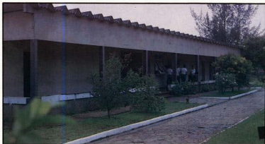
Fachada da Escola, junto à APM.
