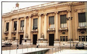
Fachada do Palácio Piratini onde está sediada a Casa Militar
