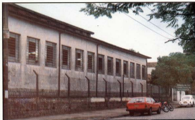
Fachada da DP15 - Seção de Recrutamento e Seleção, à rua Felipe de Oliveira n.º 2.
