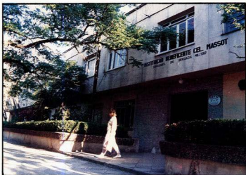
Fachada da IBCM, a rua Barão do Triunfo, nº 175
