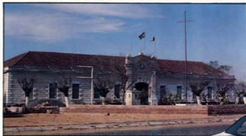
Fachada do Quartel – Santana do Livramento
