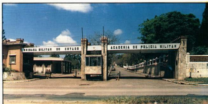
Pórtico de entrada do Quartel
